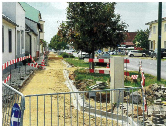
Großbaustelle Neudorferstraße mit Radweg, Schaffung von Parkplätzen, Reduzierung der Straßenbreite und Kabellegung der Netz Burgenland
