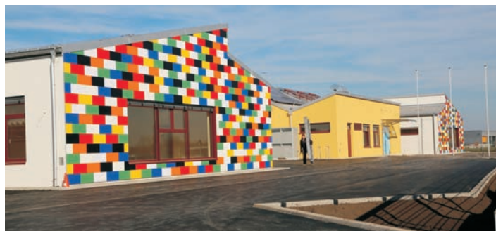
Fassade Zieselweg – mit den beiden bunten Giebfassaden
